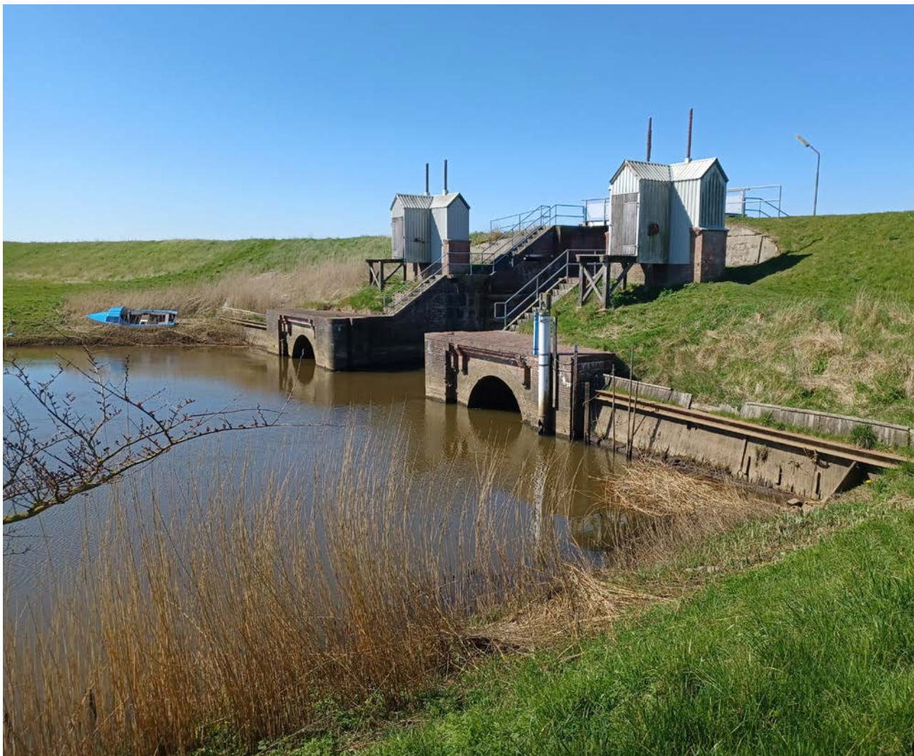
Slusen i det gamle dige ved Højer
