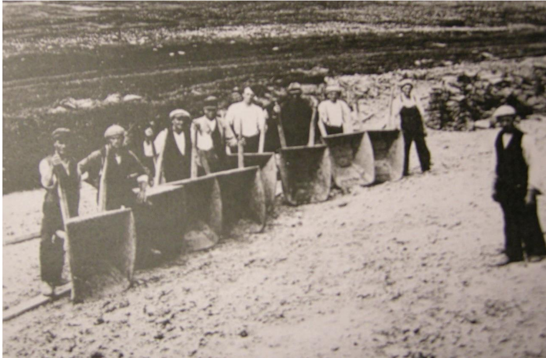
Der var hundredvis af mennesker i arbejde, når et dige skulle bygges.
